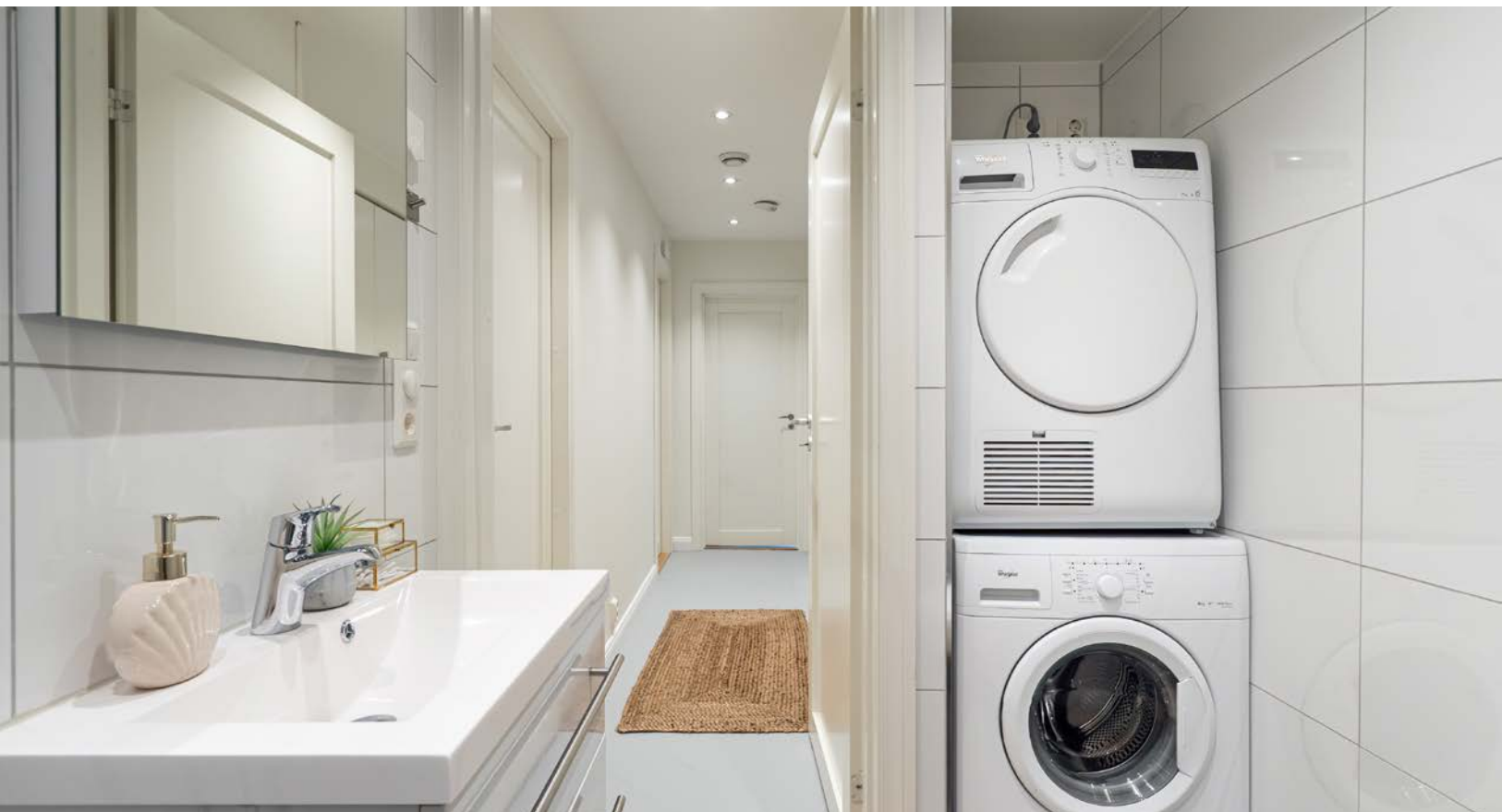
Egen søyle med opplegg for vaskemaskin og tørketrommel.
