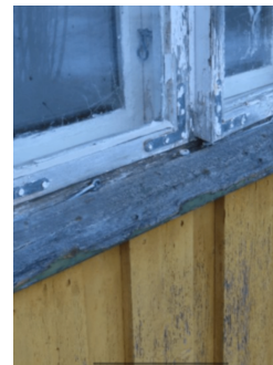
Spalte direkte inn i vegg under vinduer.
