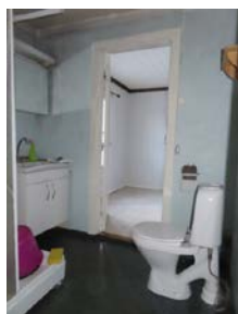
Del av bad. Gulvmontert toalett og servantskap.
