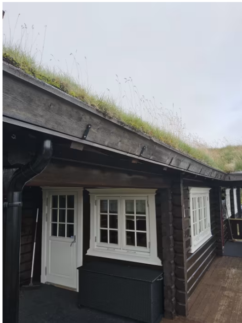
Bilde viser innkasset takrenne.
