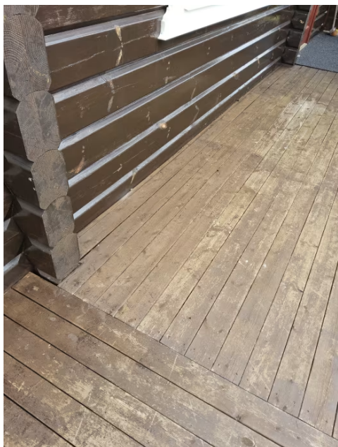
Bilde viser terrasse som skjuler grunnmur.
