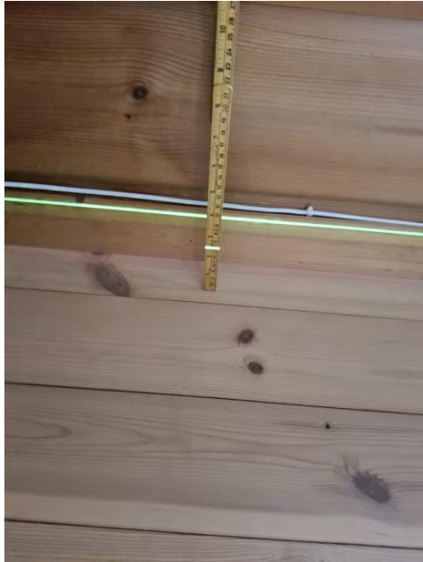
Bilde viser måling av etasjeskiller.
