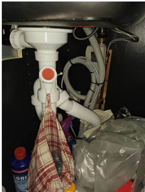
Bilde viser avløpsrør under oppvaskkum på kjøkken.
