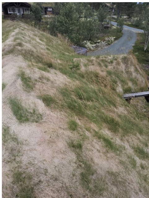
Bilde viser torvtak.
