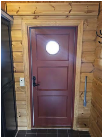
Bilde viser entrédør.
