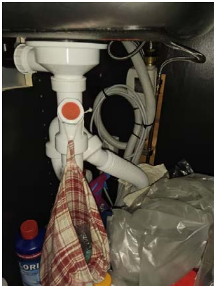
Bilde viser avløpsrør under oppvaskkum på kjøkken.
