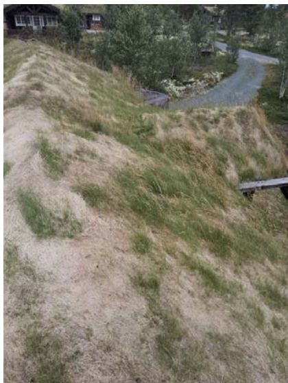
Bilde viser torvtak.
