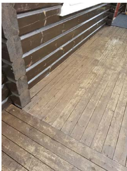
Bilde viser terrasse som skjuler grunnmur.
