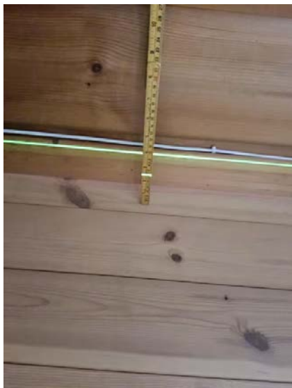
Bilde viser måling av etasjeskiller.
