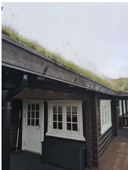
Bilde viser innkasset takrenne.
