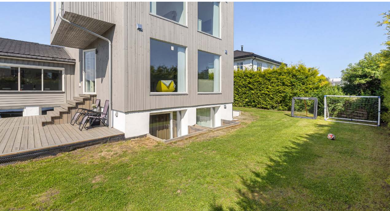
Uteområde med plen og beplantning. Rundt eiendommen er det hekk.
