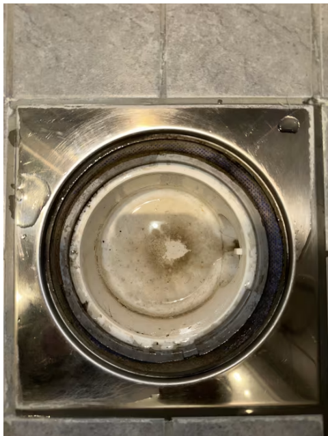
Viser sluk i dusjsonen
