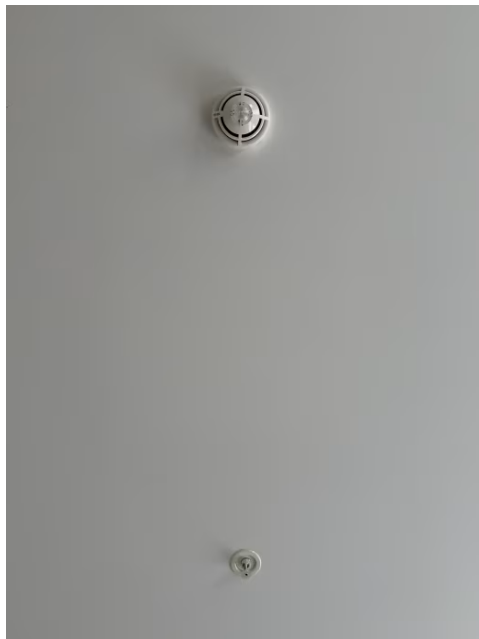
Viser brannvarsling og sprinkling
