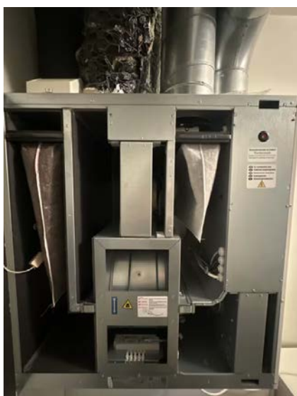
Viser innvendig balansert ventilasjonsaggregat, ingen tegn til fukt eller mugg i filter.
