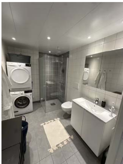
Viser baderomsinnredning, vegghengt toalett med innebygget systerne, dusjhjørne med glassdører og opplegg for vaskemaskin og tørketrommel.
