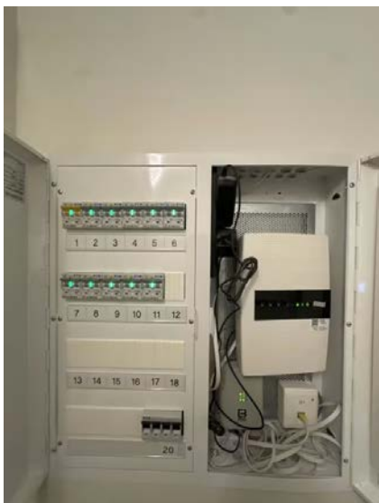
Viser innfelt sikringsskap med automatsikringer og ekom del plassert på teknisk rom.
