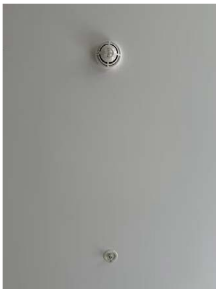
Viser brannvarsling og sprinkling
