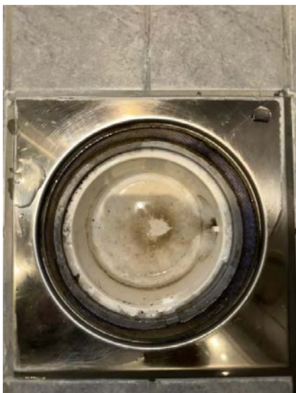
Viser sluk i dusjsone
