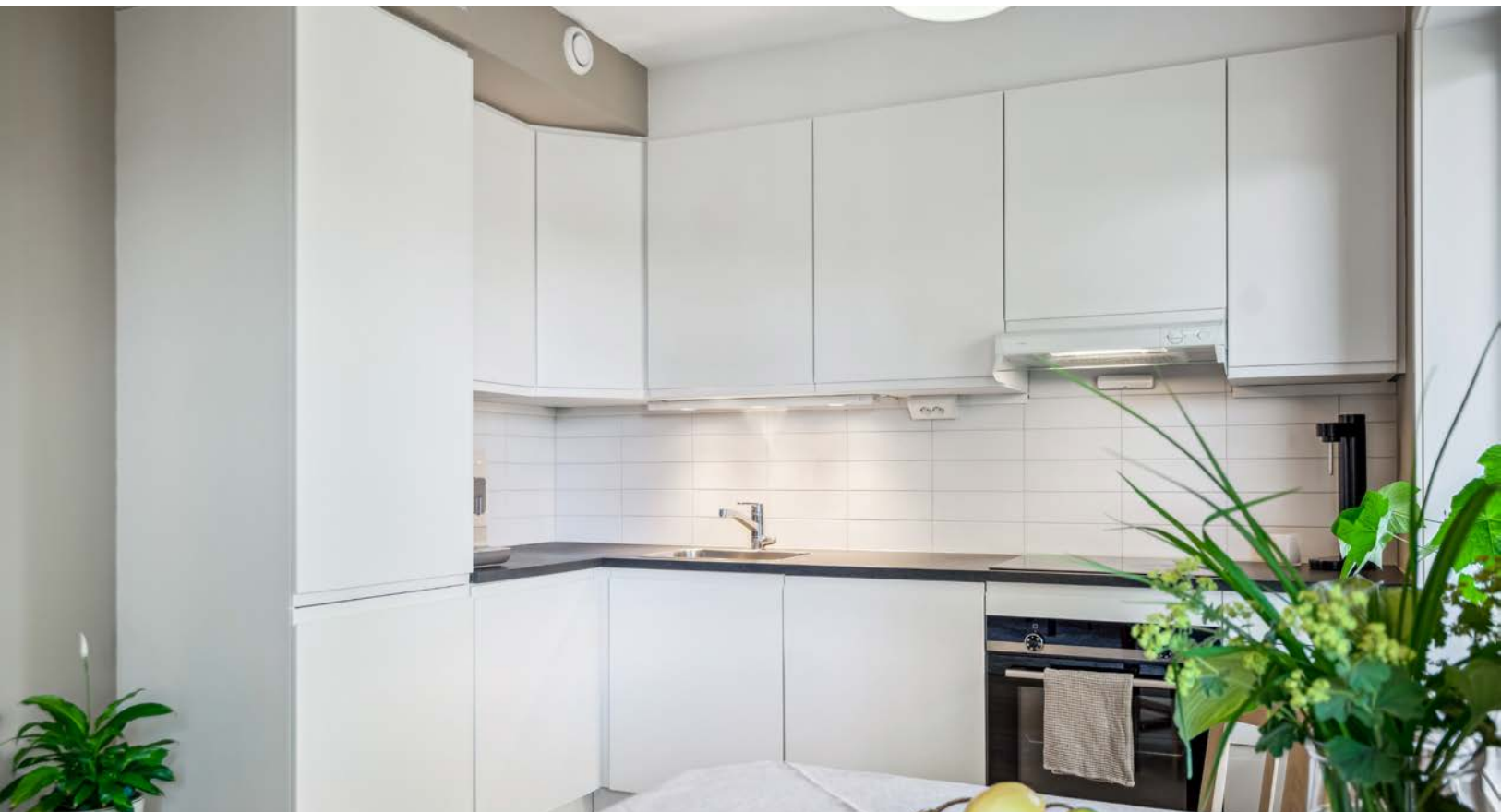
Laminat benkeplate og fliser mellom benk og overskap.
