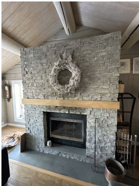
Viser ildsted i stue 1.etasje
