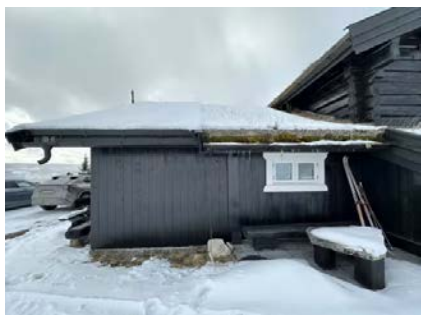
Viser takrenner av tre og metall.
