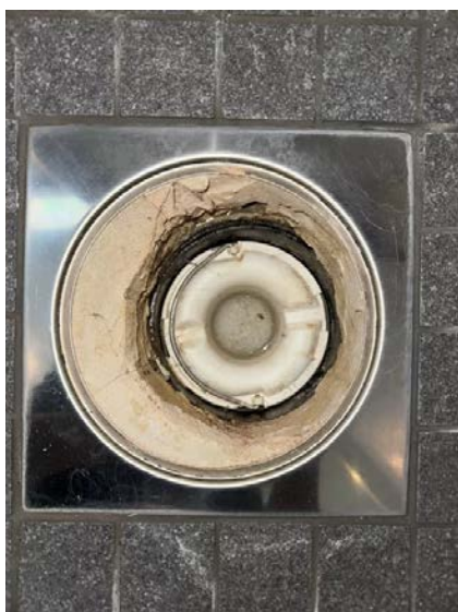
Viser sluk i dusjsonen.
