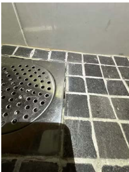
Viser utettheter rundt slukrist.
