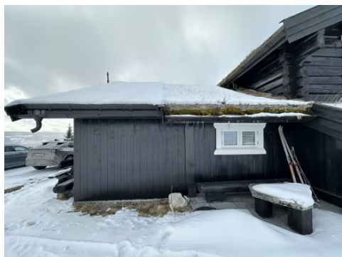
Viser takrenner av tre og metall.
