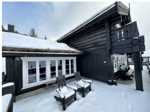
Terrasse, balkong og plattinger er snødekt og ikke kontrollert.
