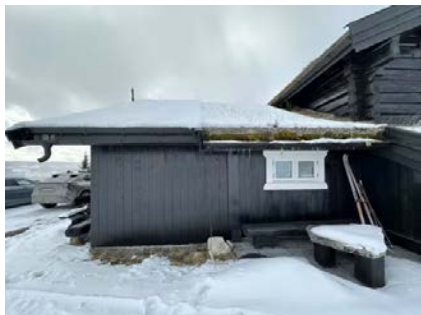
Viser takrenner av tre og metall.
