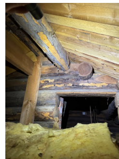
Pipe inntil tømmervegg på loftet.
