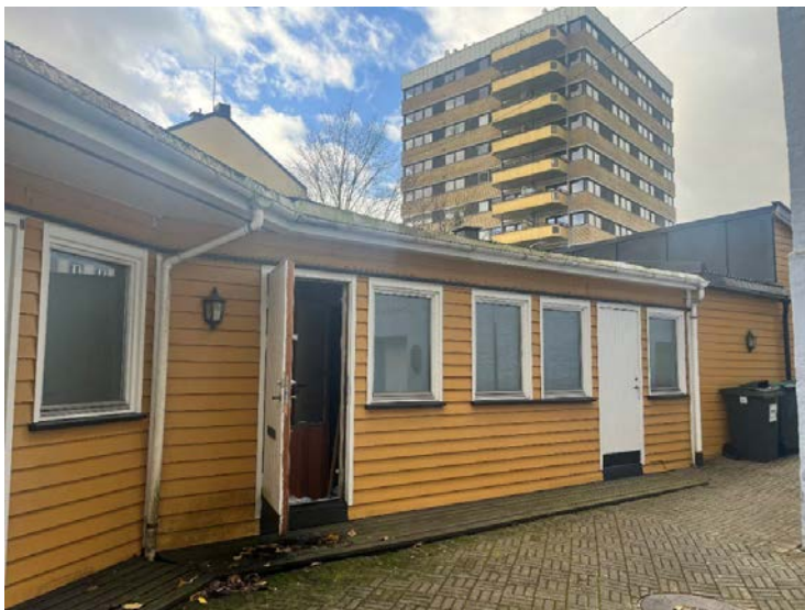
Bilde 2: Bakgård retning gate, bygg fra 1988/89, dato: 21.10.24
