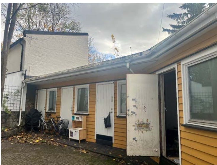
Bilde 3: Bakgård, Bygg fra 1988/89, dato: 21.10.24
