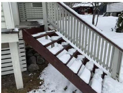
Manglende rekkverk.
