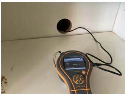
Fuktmåling i tilstøtende rom.
