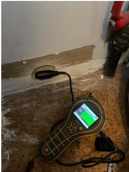
Fuktmåling i vegg under terreng.
