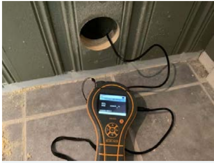
Hulltaking i tilstøtende rom.
