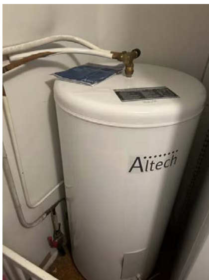
Varmtvannsbereder.
