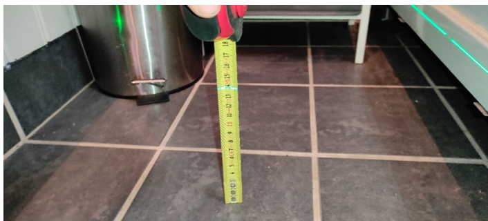
Kontroll av fall mot sluk.
