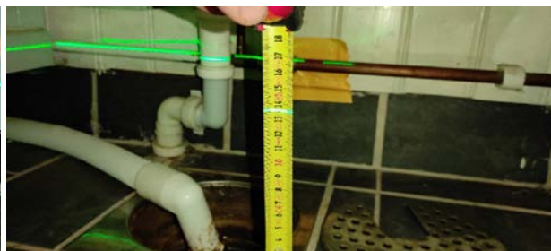
Kontroll av fall mot sluk.
