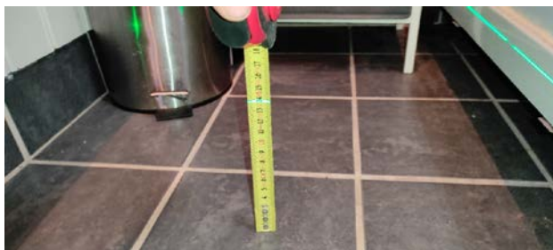
Kontroll av fall mot sluk.
