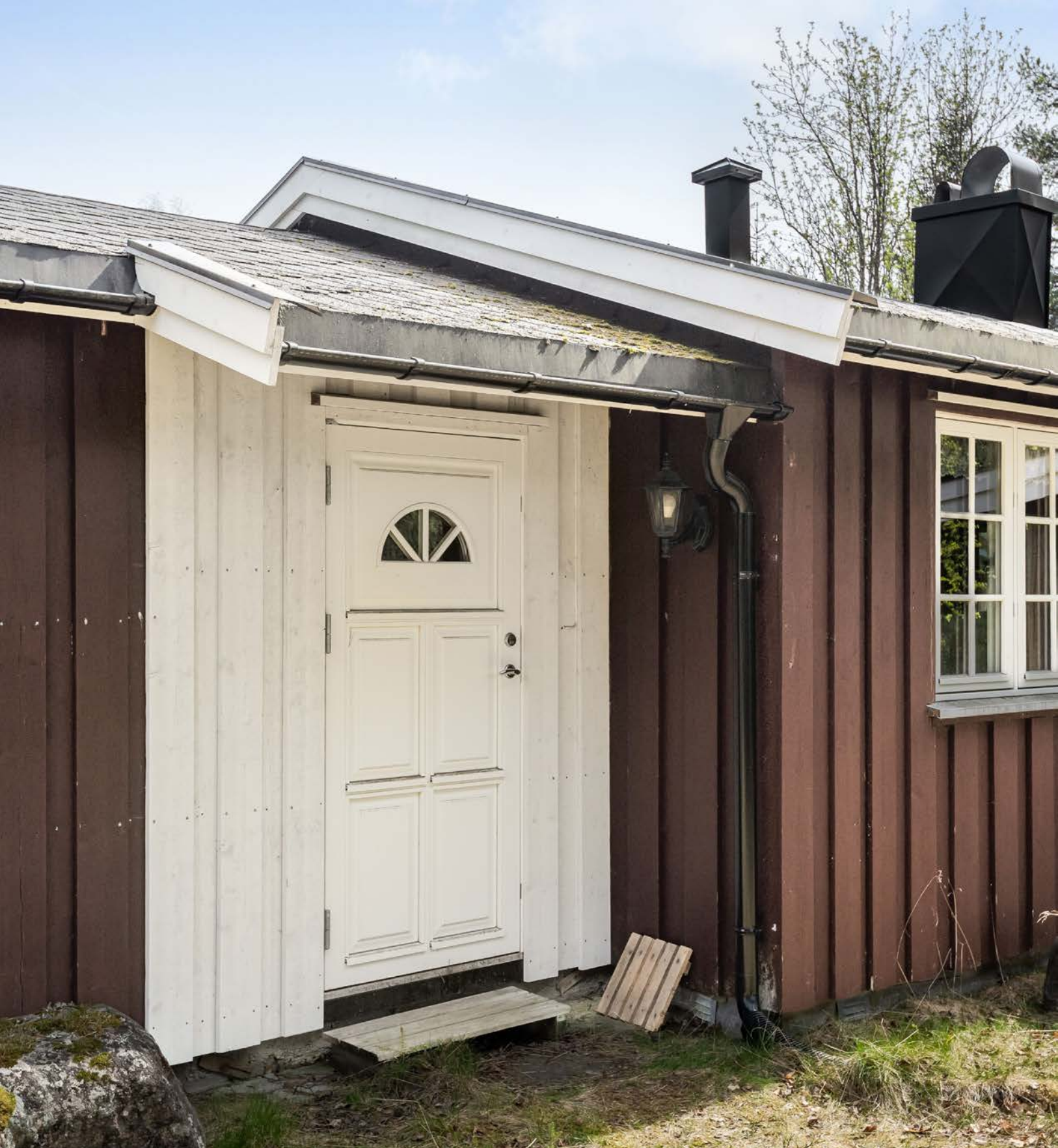
Entréen ble bygget inn i 2018 og inngangsdøren ny den gang.
