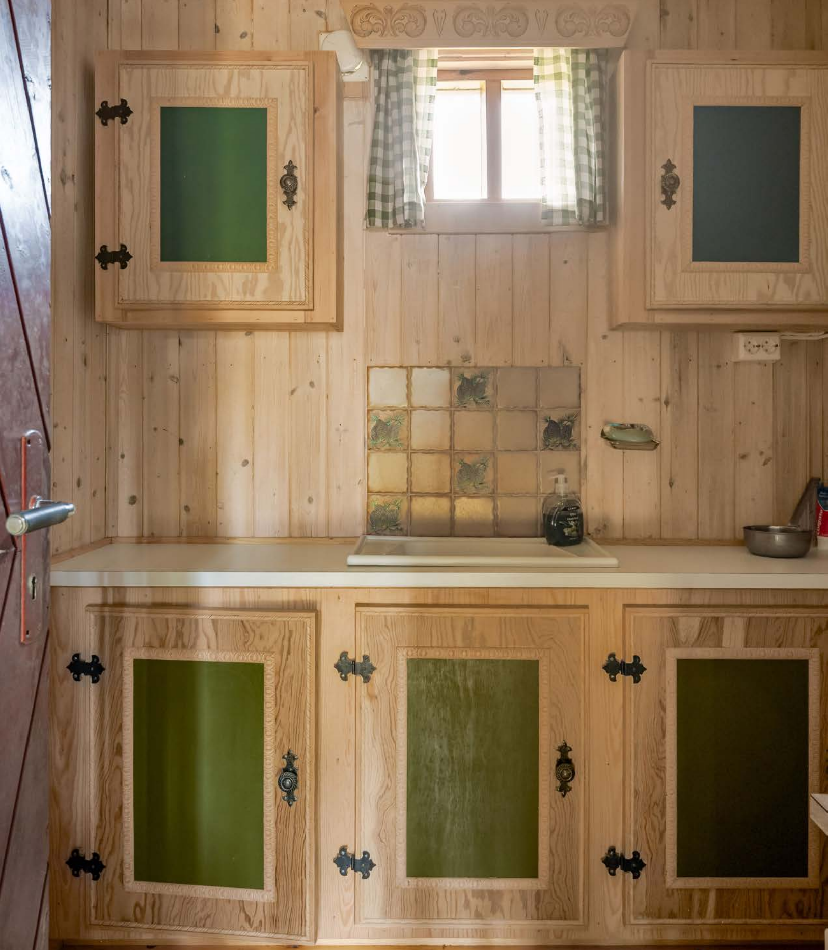
Sanitærrum med benk- og skapinnredning. Utslagsvask med avløp til terreng.
