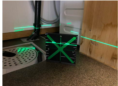
Måling av fallforhold til sluk.
