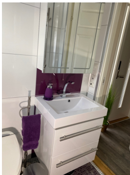
Dør/vindu er plassert i våtsonen
