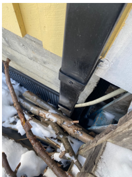
Manglende klemlist mot vorteplast.
