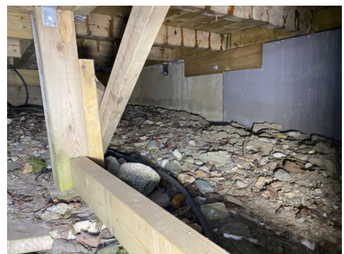
Betongmur under inngangsparti
