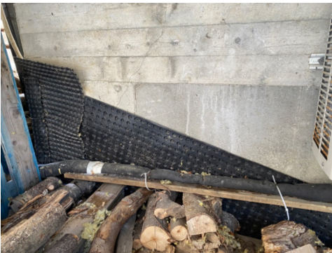
Manglende klemlist mot vorteplast.
