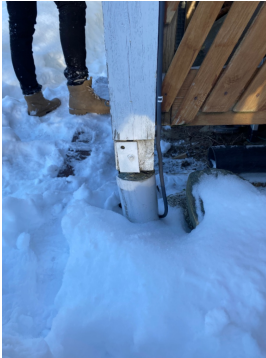
Skjevheter i fundamentering mot søyle.
