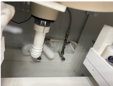
Kontroll av røropplegget.
