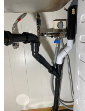
Kontroll av røropplegget, manglende vannlås.
