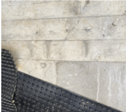
Skrårriss. Ubehandlet betongmur.
