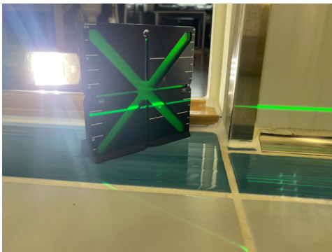
Måling av fallforhold fra dør.
