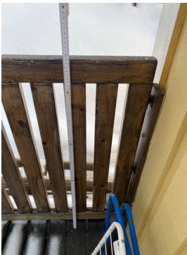
Skjevheter i fundamentering mot søyle.
