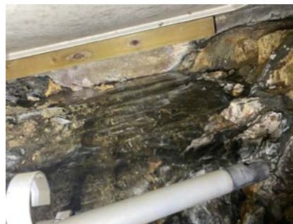
Is registrert mot grunnen.
