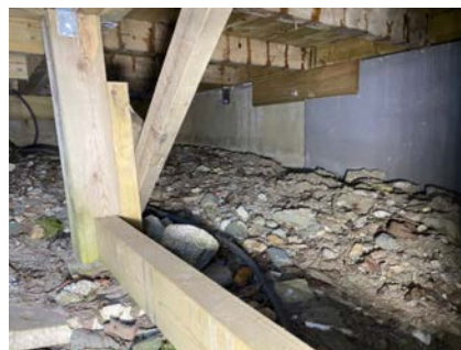
Betongmur under inngangsparti
