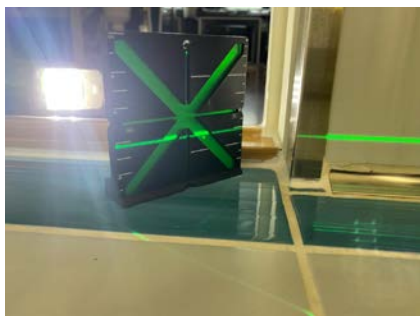
Måling av fallforhold fra dør.
