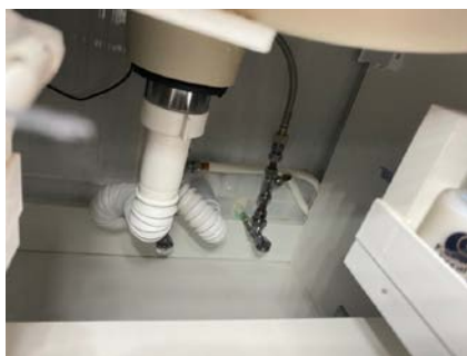
Kontroll av røropplegget.
