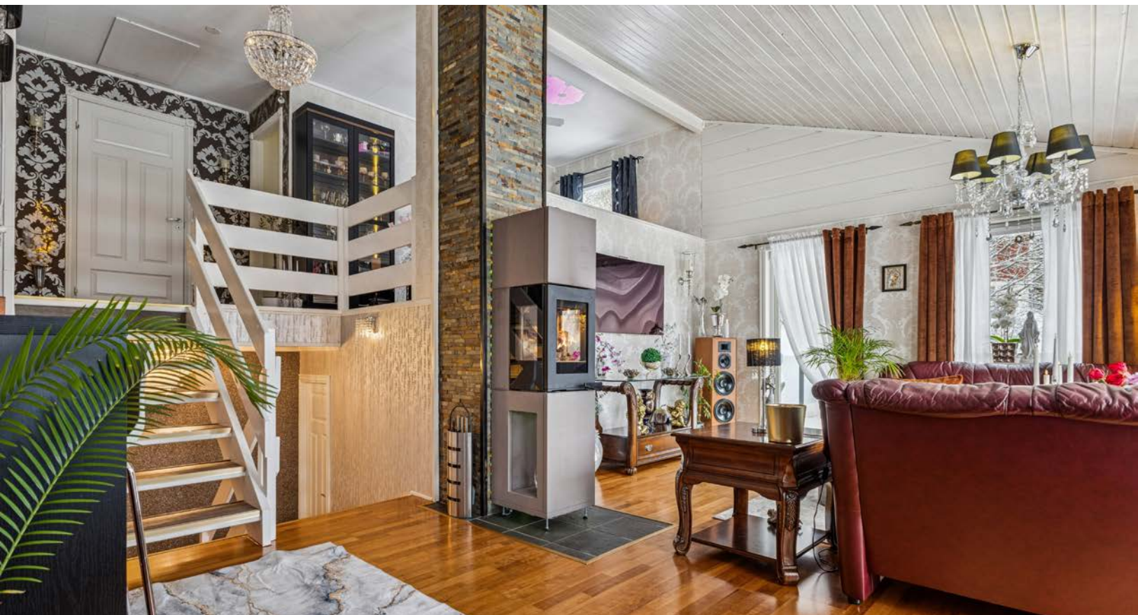
Vedovn i stuen gir effektiv oppvarming og er nylig installert.
