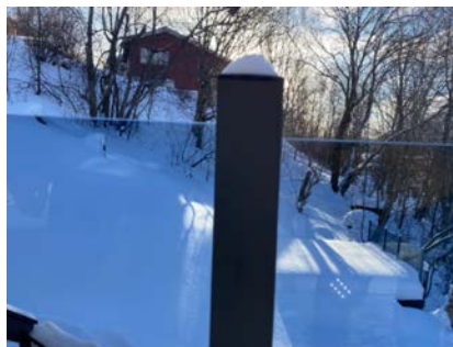
Enkelte trapper i glassrekkverk.
