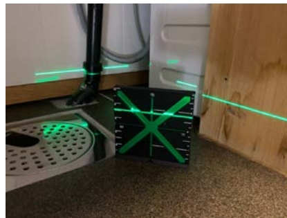
Måling av fallforhold til sluk.
