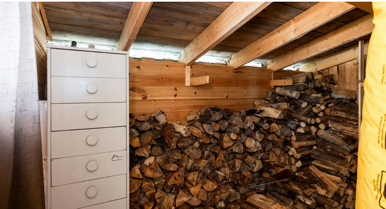
Eiendommen er også bebygd med uthus/vedbod på 4m 2 fra ca. 2015.
