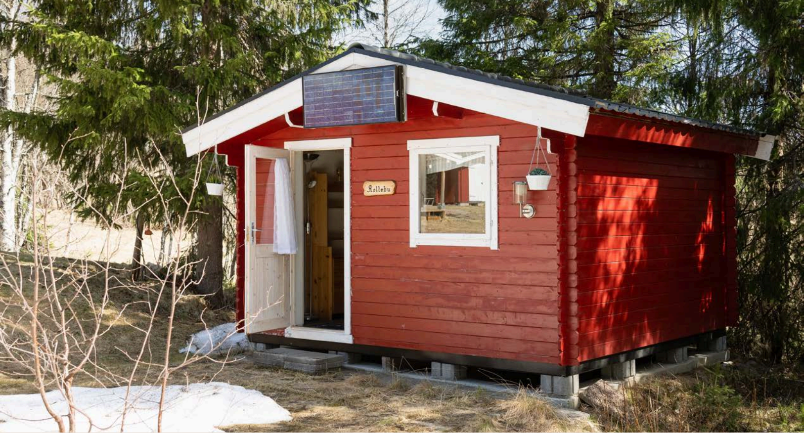
Eiendommen er også bebygd med et anneks på 12m 2 fra ca. 2015. Solcelleanlegg med ett stykk batteri montert på anneks.
