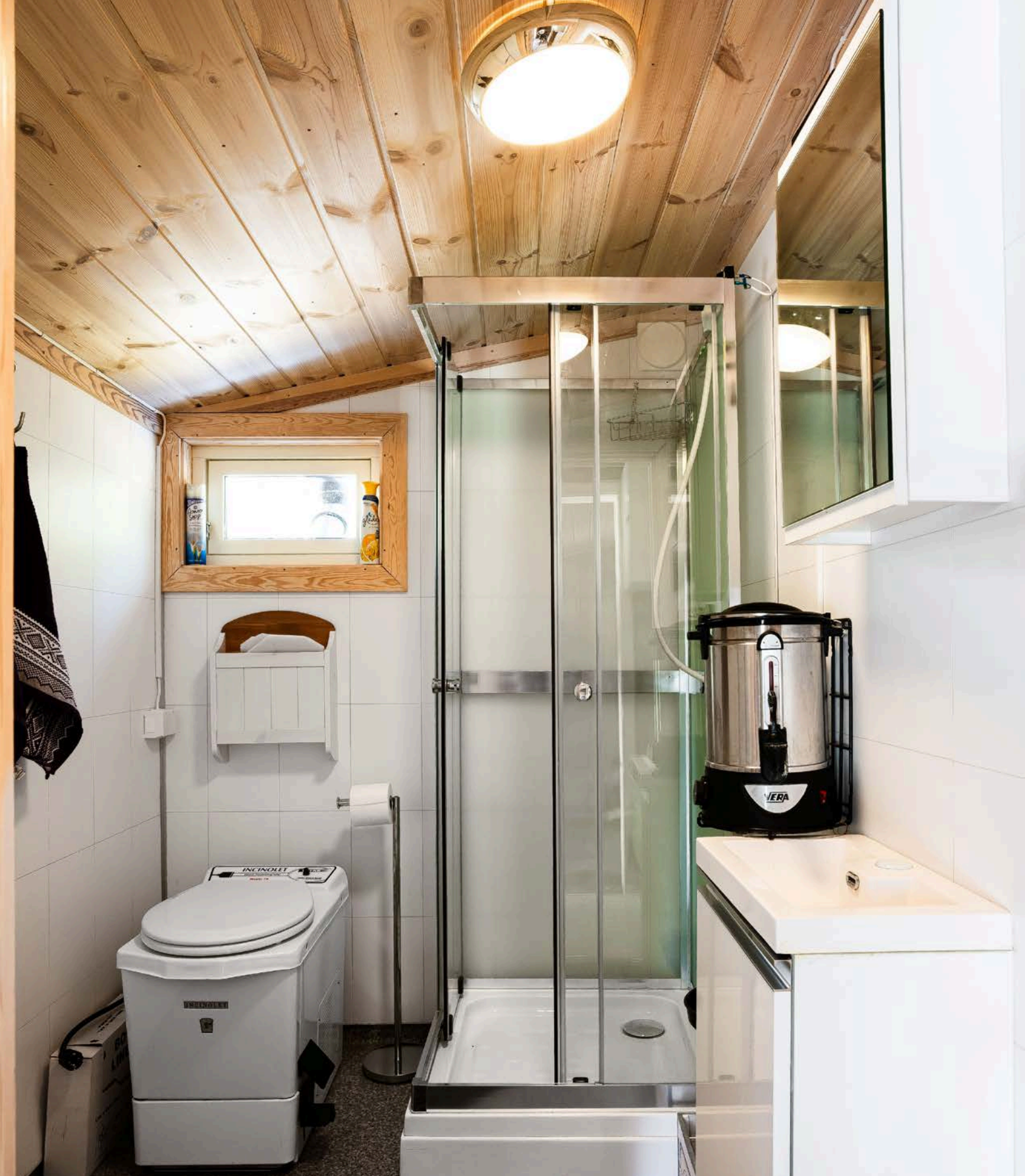
Hygienerom oppusset i ca. 2021 med belegg på gulv og baderomsplater på veggene. Rommet er utstyrt med baderomsinnredning, speilskap, dusjkabinett og forbrenningstolett.
