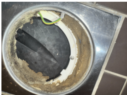
Kontroll av hjelpesluk i dusj.
