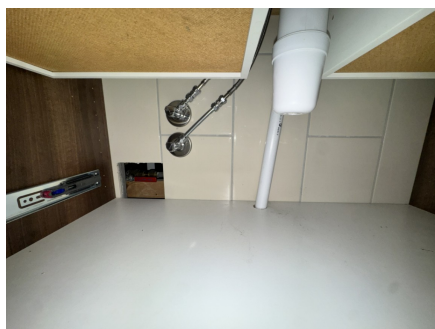
Hull/åpning i baderomsvegg.
