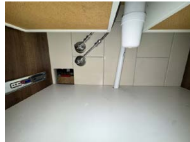
Hull/åpning i baderomsvegg.
