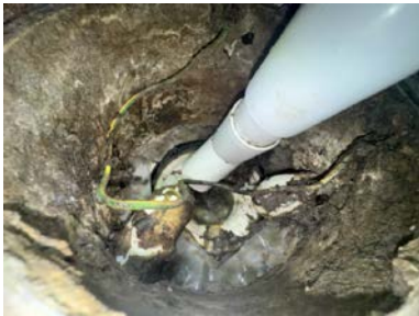
Kontroll av hovedsluk under servantskap.
