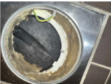
Kontroll av hjelpesluk i dusj.
