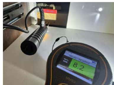
Fuktmåling med pigg i tilgjengelig treverk via hull/åpning bak servantskap
