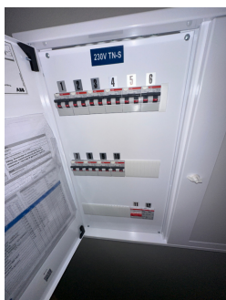
Sikringsskap med automatsikringer.
