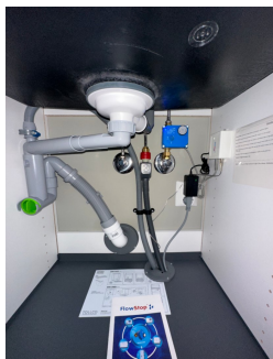
Røropplegg i kjøkkenbenk med Waterguard
