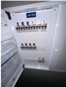
Sikringsskap med automatsikringer.
