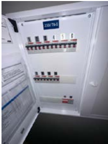
Sikringsskap med automatsikringer.
