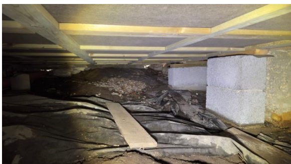
Inspeksjon av stubbloftskonstruksjon under hytta.
