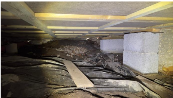
Inspeksjon av stubbloftskonstruksjon under hytta.
