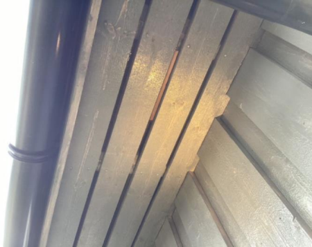
Lufting av kaldloft ved raft.
