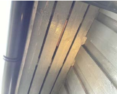
Lufting av kaldloft ved raft.
