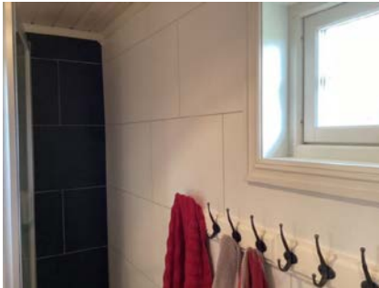
Vindu i våtzone.
