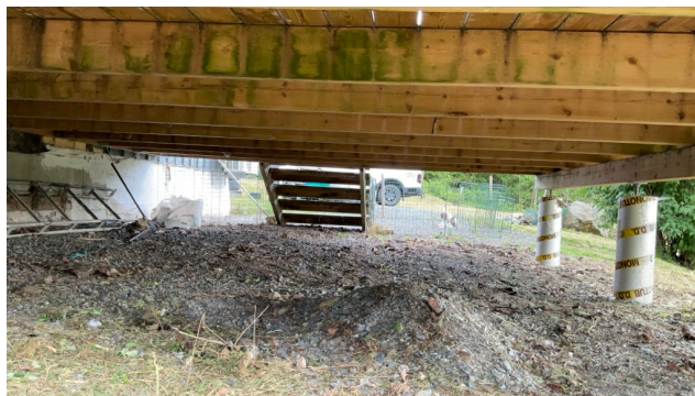
Eksempel på langt spenn på bærebjelker.
