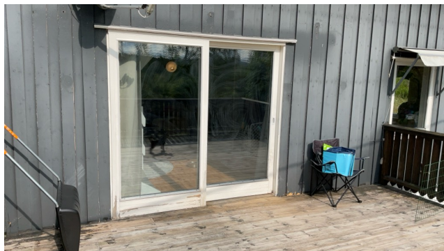
Skyvebalkongdør i malt tre.
