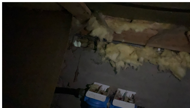
Ventilluke delvis tettet med isolasjon.
