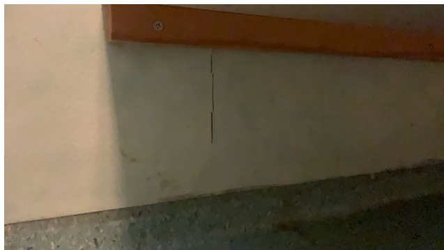
Utette skjøter i belegg/tapet.
