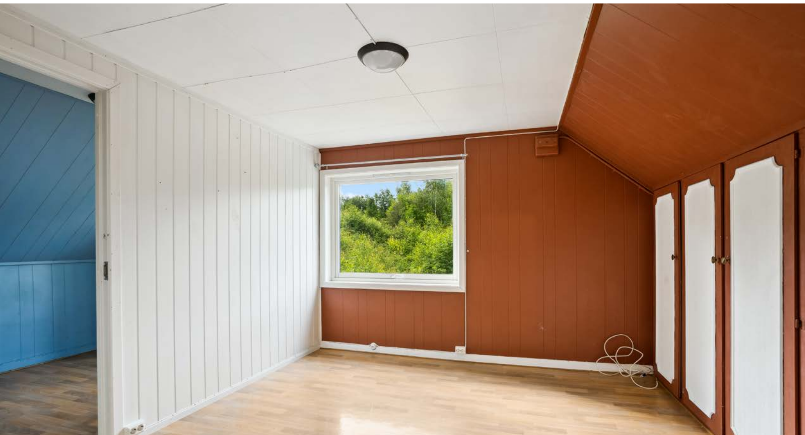
Ett soverom har adkomst via et annet soverom.
