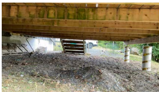
Eksempel på langt spenn på bærebjelker.
