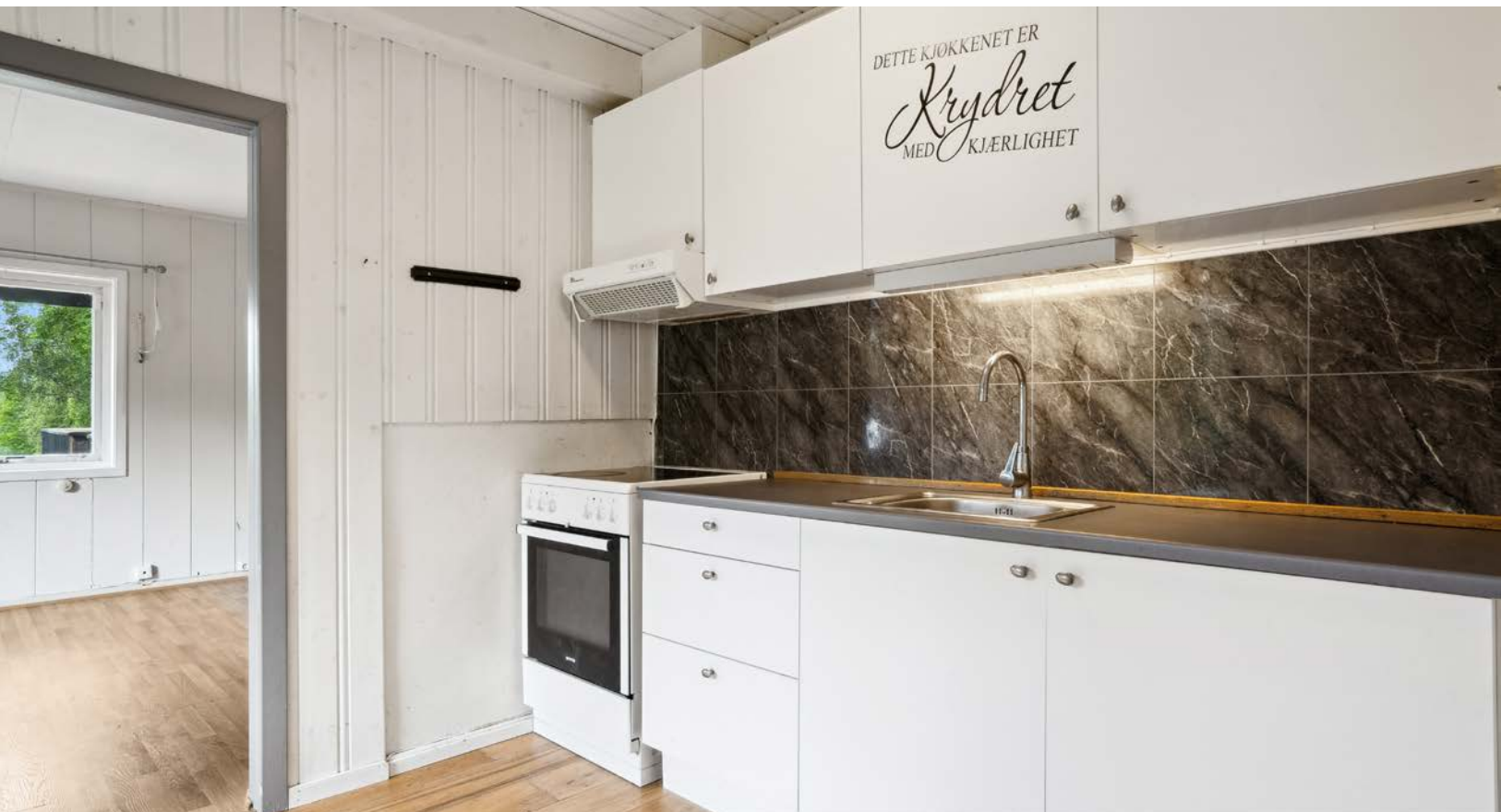
Det er montert veggplater som ser ut som fliser mellom over og underskap.
