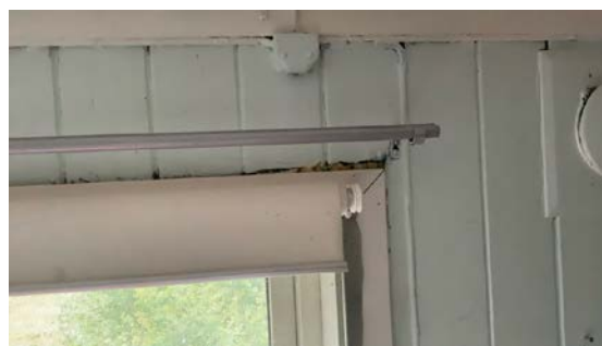
List dekker ikke. Noe kladd på kladd med maling.
