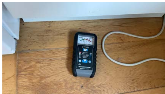
Ingen fukt rundt utsatte hvitevarer.
