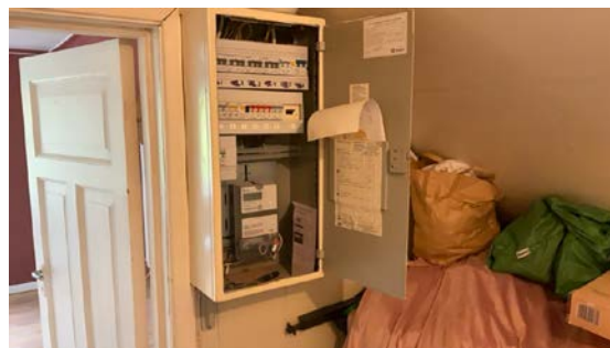
Sikringsskap med kursfortegnelse i samsvar med antall sikringer.
