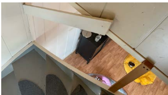
Store åpninger i rekkverk.
