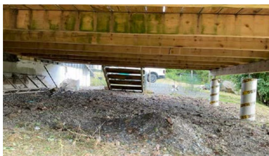
Eksempel på langt spenn på bærebjelker.
