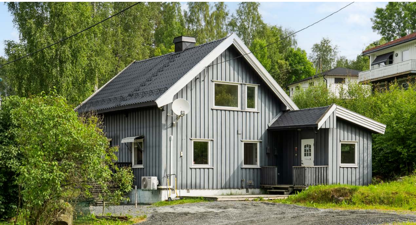
Eldre enebolig med behov for vedlikehold og modernisering.
