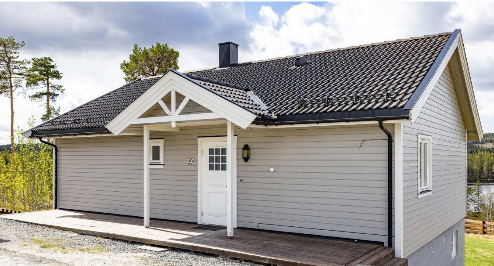
Overbygd inngangsparti med plattning. På høyre side er det trapp ned til hagen.
