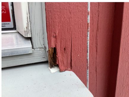
Råteskadet omramming.
