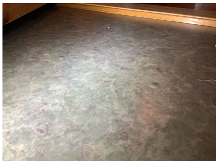
Eksempel på kuler i vinylbelegget.
