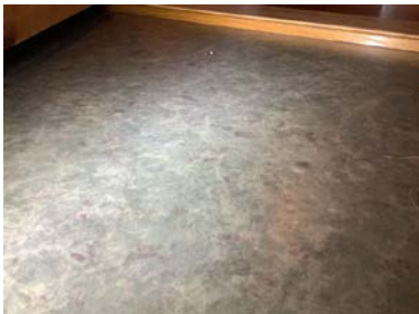
Eksempel på kuler i vinylbelegget.
