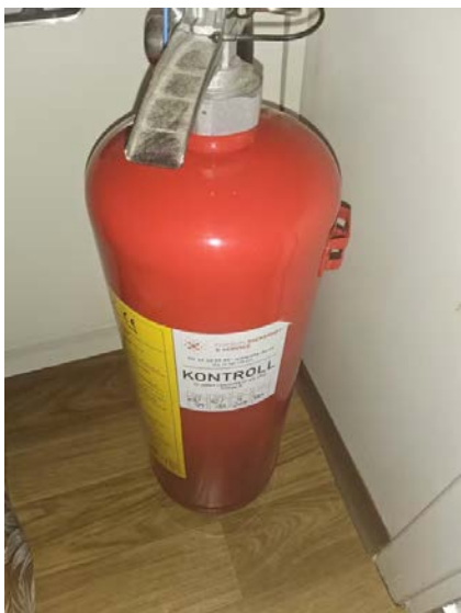
Brannslukningsapparat er plassert i bod.
