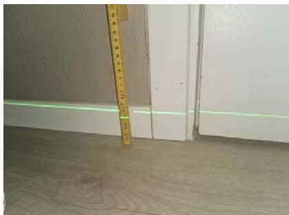
Etasjeskille ble kontrollert med nivelleringslaser.
