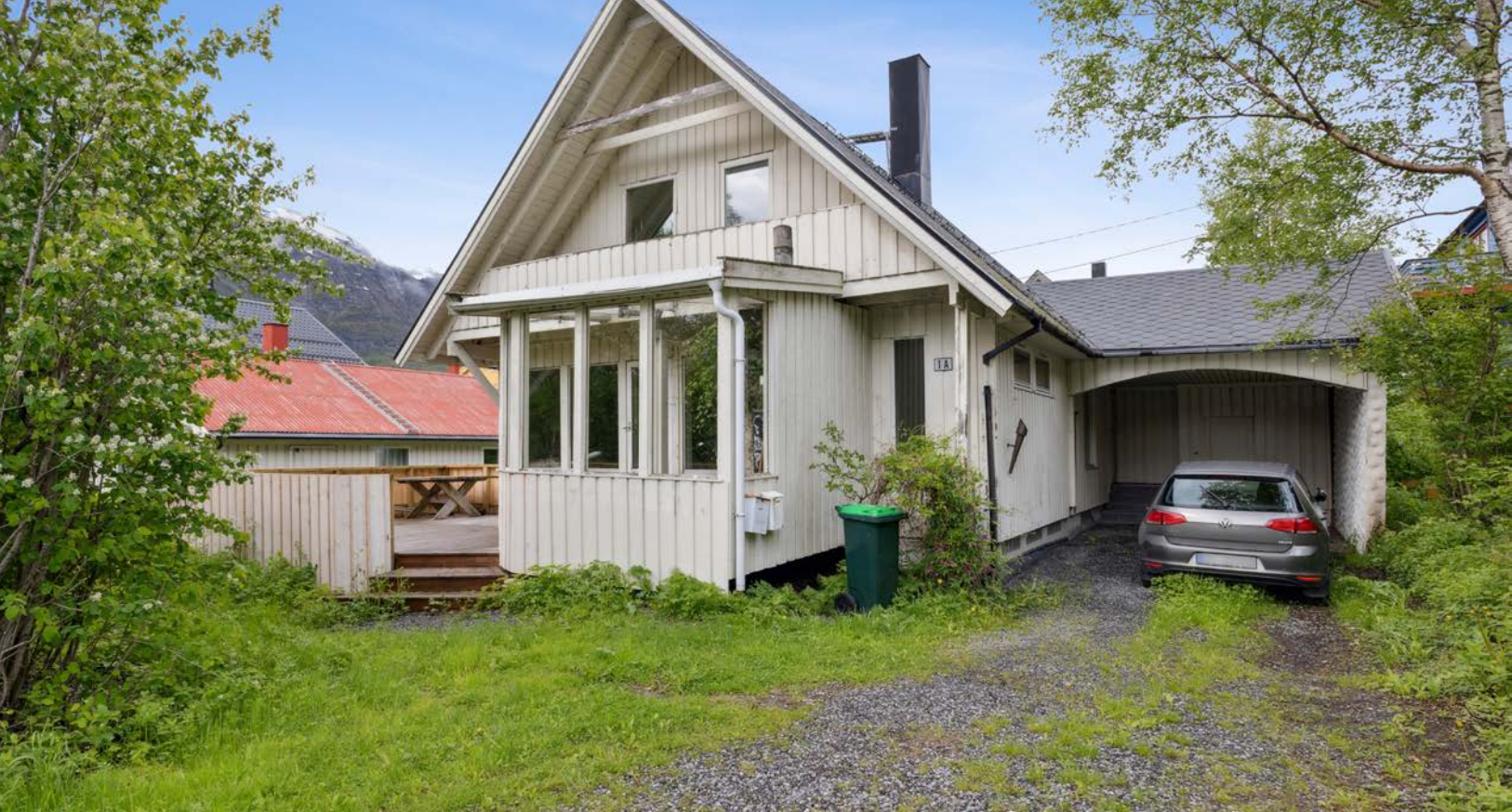
Fasade fra veien. I tillegg til carport er det også plass til biloppstilling i innkjørsel
