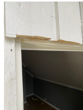
Ikke fagmessig utførelse av kledning
