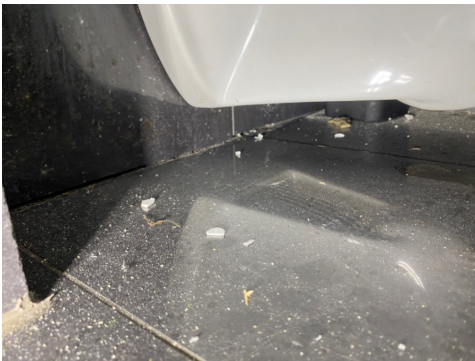
Ingen synlig drengs pning
