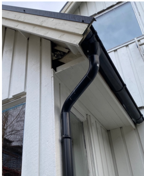
Lite eller ingen lufting via raft.
