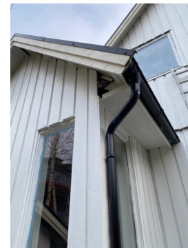
Ikke fagmessig utførelse av kledning
