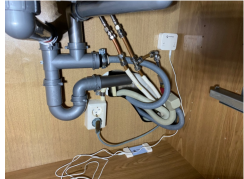
Kontroll av røropplegget.
