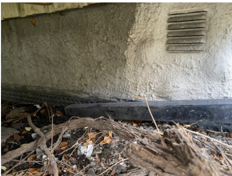
Nedløpsrør avsluttet mot terreng.
