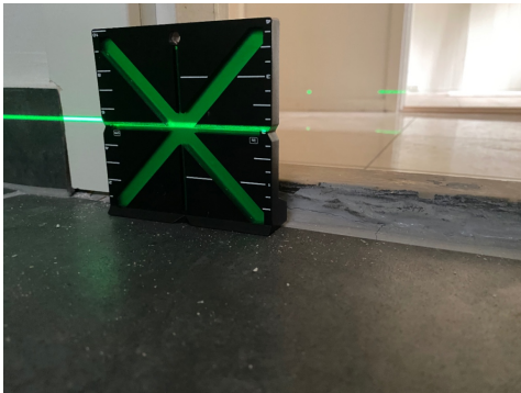
Måling av fallforhold fra dør.
