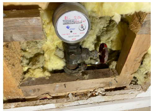
Stoppekrane plassert i kjeller for hoveddel.
