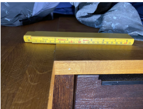
Trapping i benkeplate
