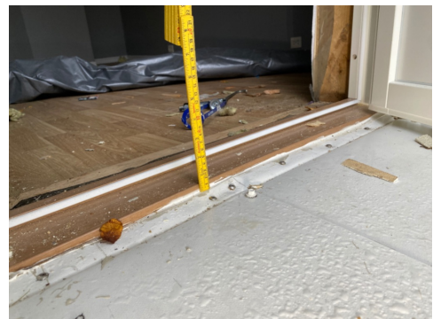
Høyde mellom beslag til terskel.
