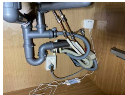
Kontroll av røropplegget.
