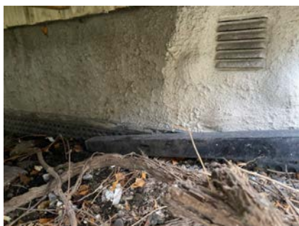
Nedløpsrør avsluttet mot terreng.
