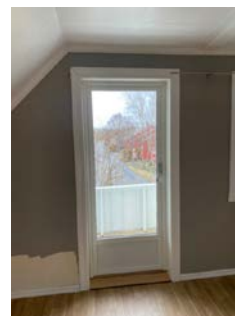
Balkongdør med utgang fra soverom.
