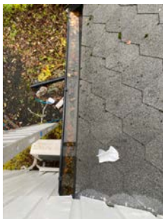
Nedløpsrør avsluttet mot terreng.
