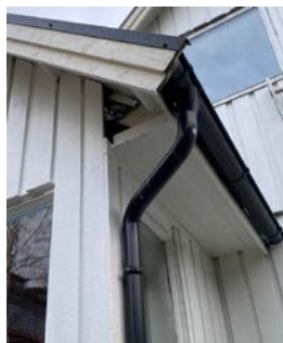
Lite eller ingen lufting via raft.
