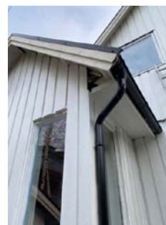
Ikke fagmessig utførelse av kledning
