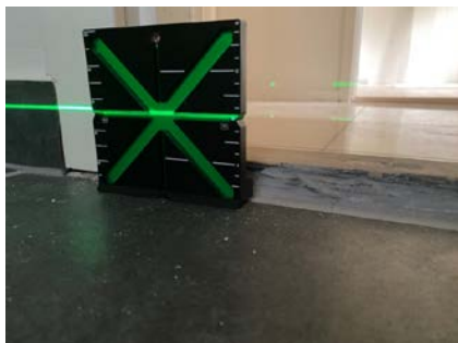
Måling av fallforhold fra dør.
