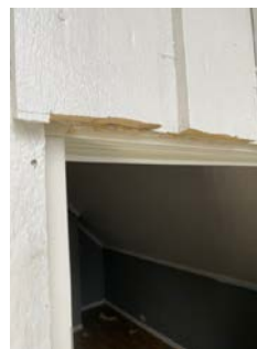
Ikke fagmessig utførelse av kledning
