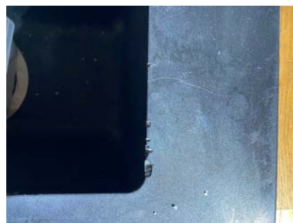
Skade i oppvaskkummen
