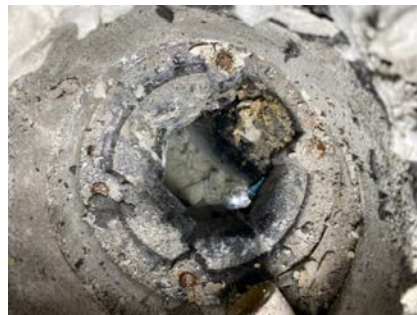
Sluk ved toalett.
