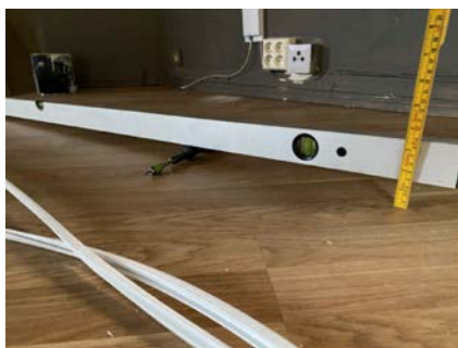
Målt høydeforskjell, loftsetasjen.
