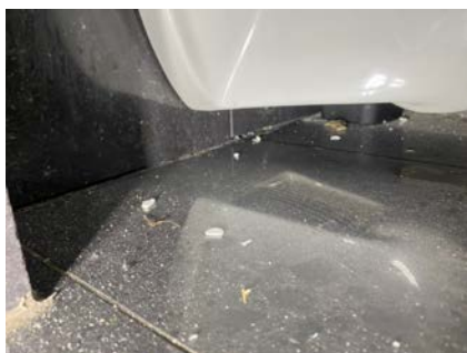
Ingen synlig drengåpning
