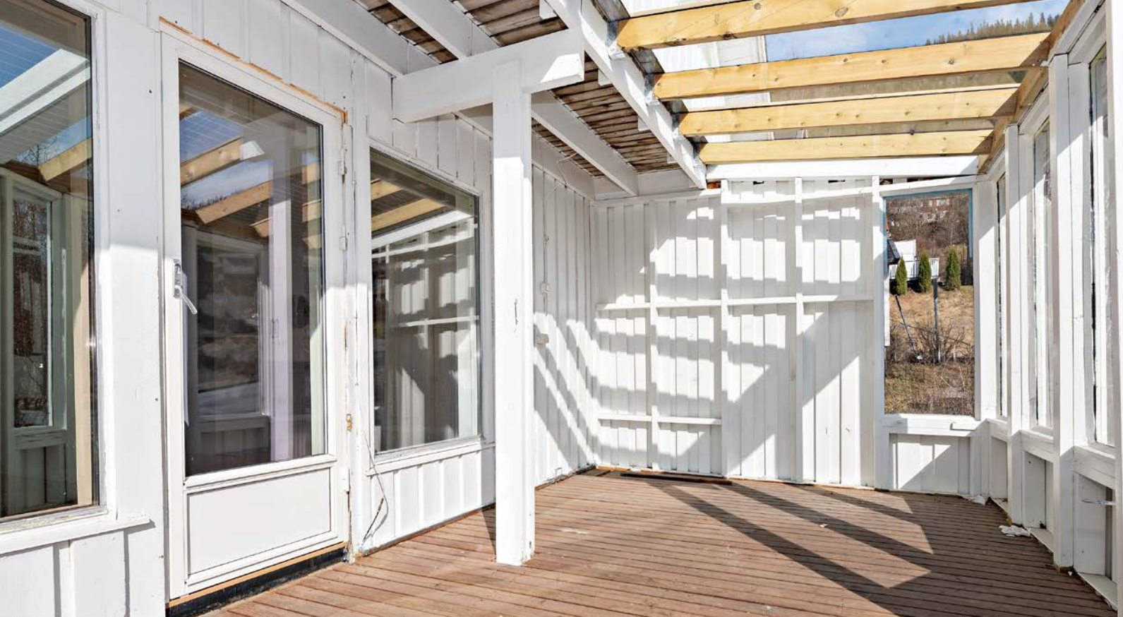
Deler av terrasse er overbygd med glasstak og gir beskyttelse mot vær og vind.
