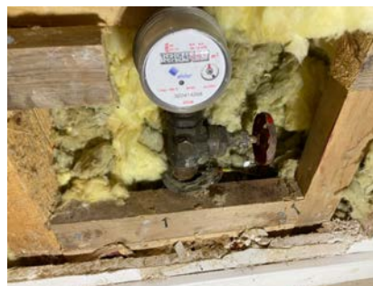
Stoppekrane plassert i kjeller for hoveddel.
