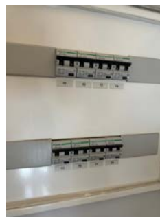
Sikringssskap med automatsikringer.
