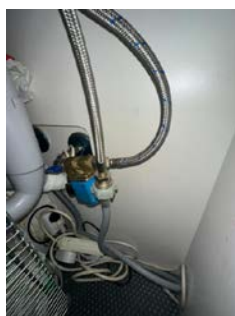
Røropplegg i kjøkkenbenk med Waterguard
