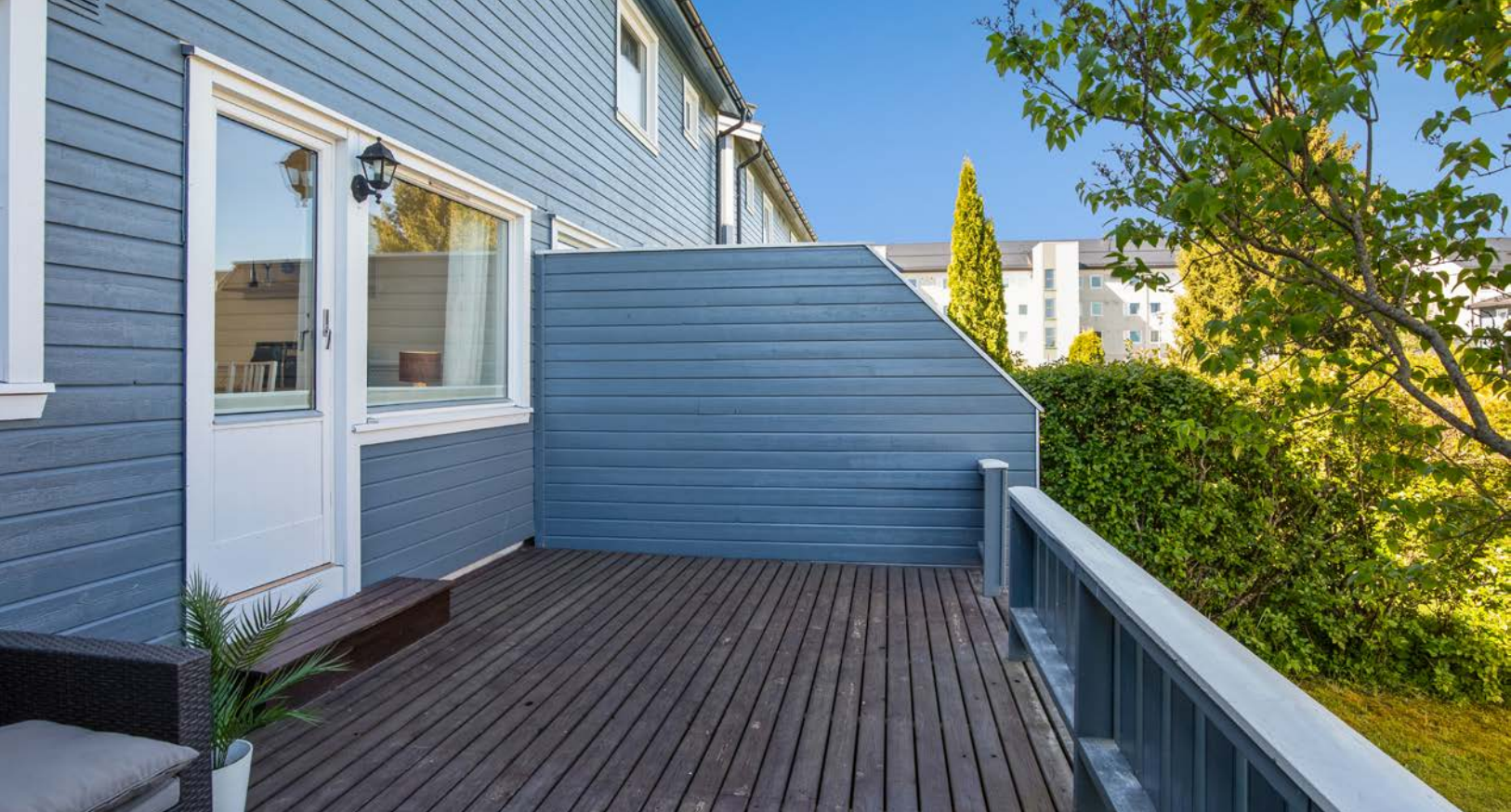
Utendørs har huset en romslig terrasse m/levegger på begge sider.
