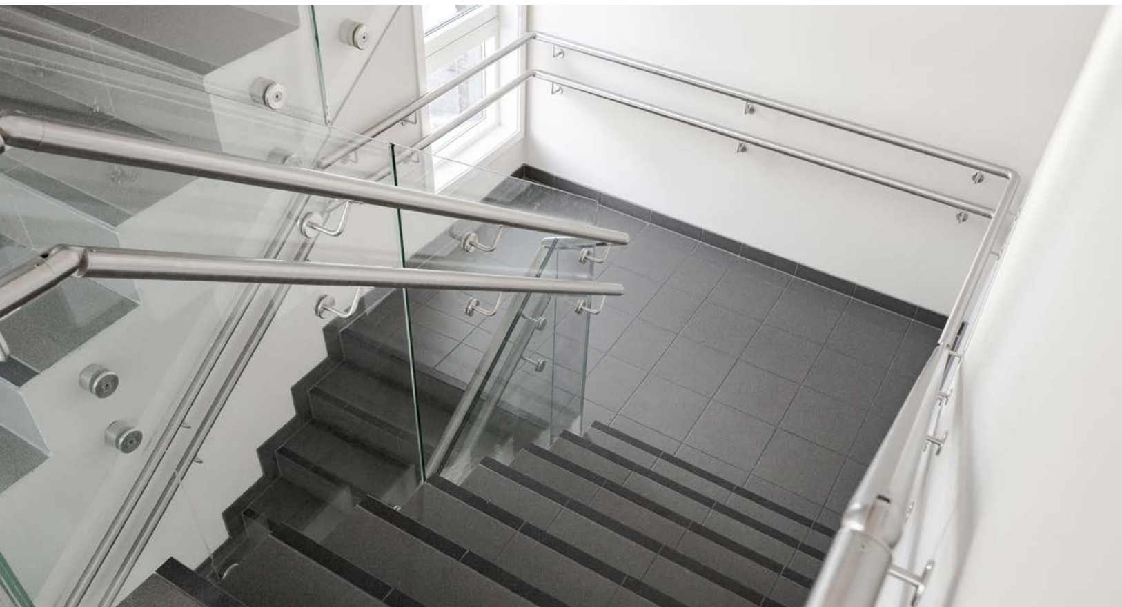
Fellesarealene har god standard med flislagt gulv, glatte lysmalte overflater, rekkverk med glassfelt og vinduer som slipper inn naturlig lys.
