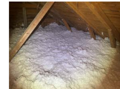
Ingen lufting mot skråtak.
