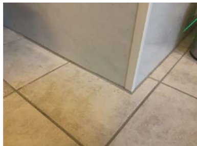
Baderomsplater er dekt med flutsparkel og fliser er lagt inntil.
