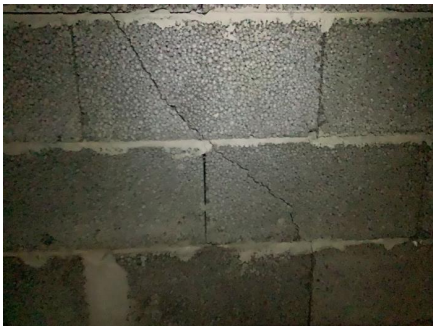
Eksempel på innvendig skråriss.
