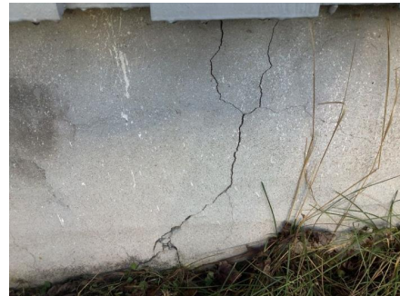
Eksempel på utvendig skråriss.
