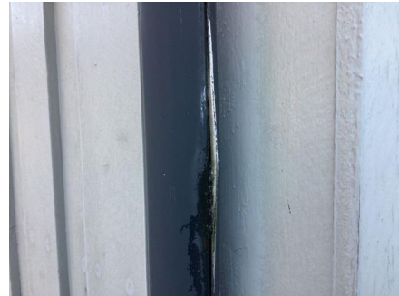
Frostsprengt nedløpsrør.
