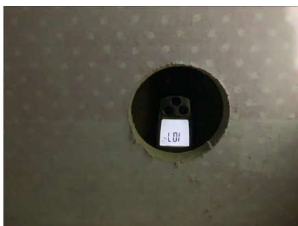
Hulltaking, og det måles tørt.
