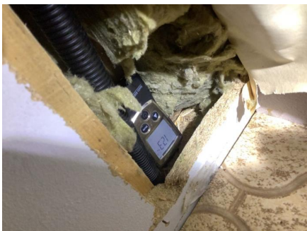
Hulltaking, og det måles tørt.
