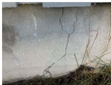
Eksempel på utvendig skråriss.
