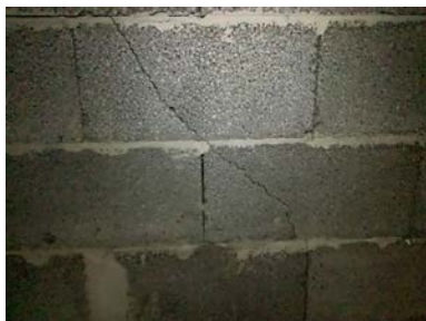
Eksempel på innvendig skråriss.
