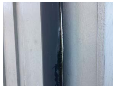
Frostsprengt nedløpsrør.
