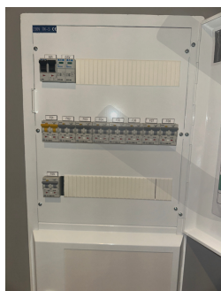
Sikringsskap med automatsikringer.
