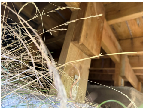
Dragere/ punktfundamentering mot terreng.
